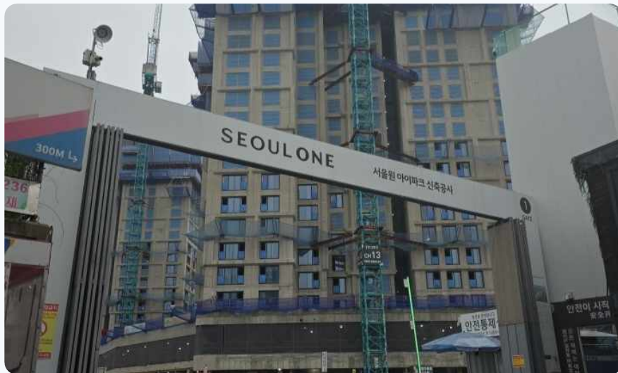
이른 아침 공사현장 점검
